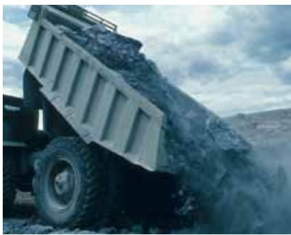
Карьеры, производители строительных материалов, дорожных покрытий
